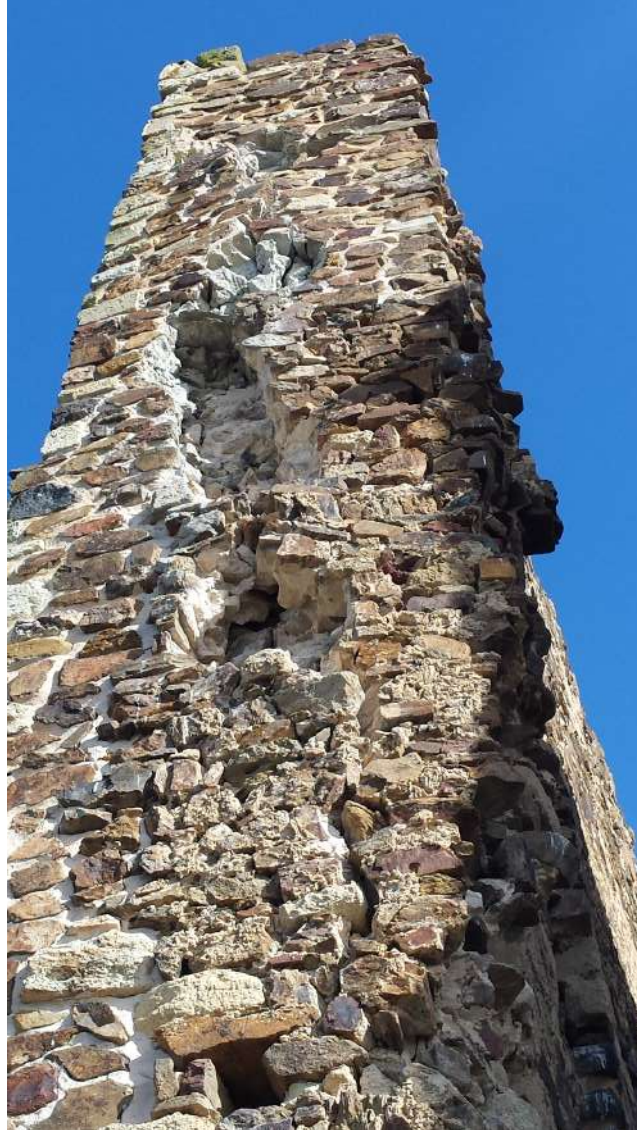
Fig. 13 - Muratura danneggiata
