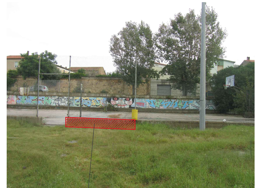
DEMOLIZIONE MURATURA IN C.A. D. 0012.0004.0012
