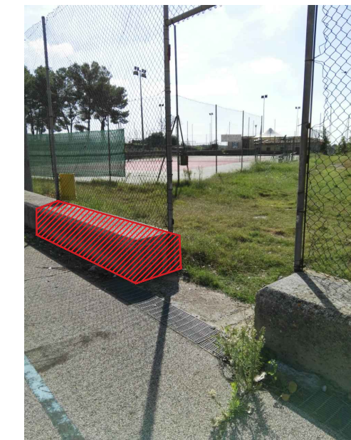
DEMOLIZIONE MURATURA IN C.A. D. 0012.0004.0012
